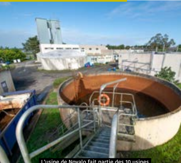
L'usine de Noyalo fait partie des 10 usines de l'agglomération en charge de la production d'eau potable.
